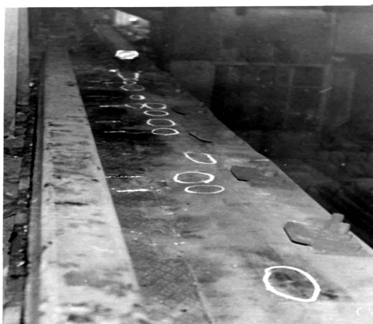
Рисунок 1 - Вид характерного контакта между рельсом и верхним поясом балки
