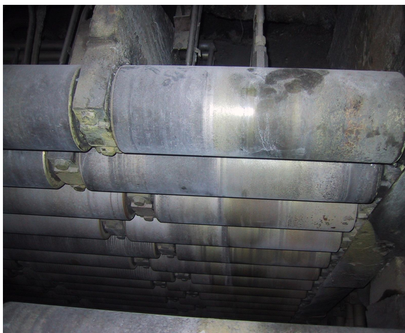
Рисунок 2 – Состояние роликов нулевой секции после длительной разливки стали 1006 на слябы сечением 250 \times 1250 мм
