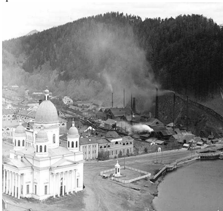
Рисунок 1 – Общий вид Златоустовского завода и собора во имя Трех Святителей
