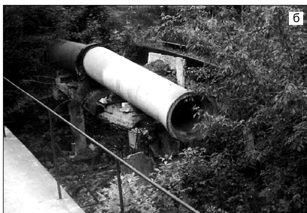
Рис. 9. Аварии трубопроводов вследствие просадки грунтов (а) и техногенных воздействий (б)
