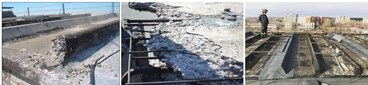
Рисунок 1 — Дефекты безрулонных крыш с ребристыми железобетонными панелями и их ремонт рулонными материалами
