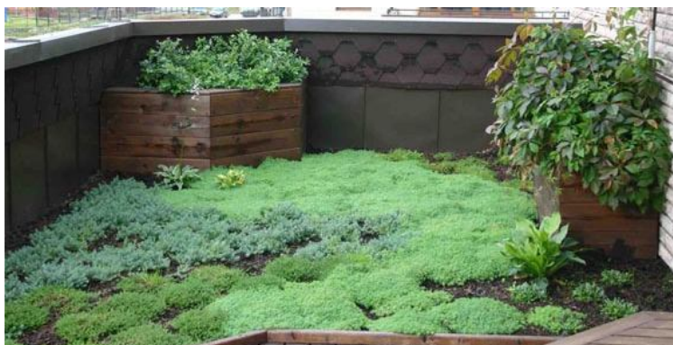
Рисунок 2 — Экстенсивное озеленение эксплуатируемого покрытия
