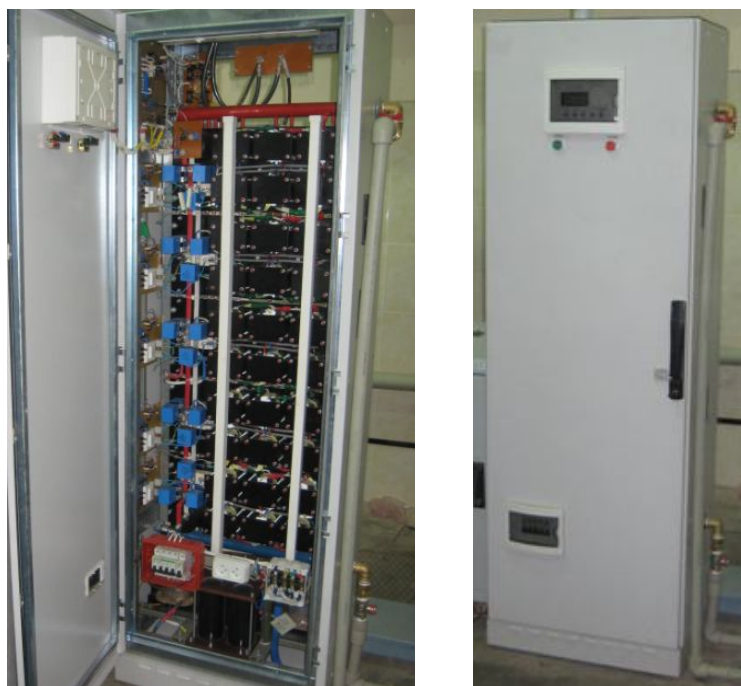
Рисунок 1 — Общий вид высоковольтного источника питания ВИП-2-15: а — общий вид функциональных узлов ВИП, при открытой двери; б — общий вид с системами ручного управления и подключенными коммуникациями
