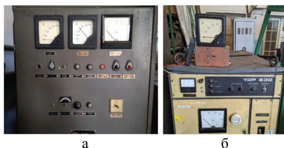
Рисунок 1 Источник питания ТИР-630 (а) и тиристорный возбудитель ТЕ8-32 (станция управления электромагнитом) (б)
