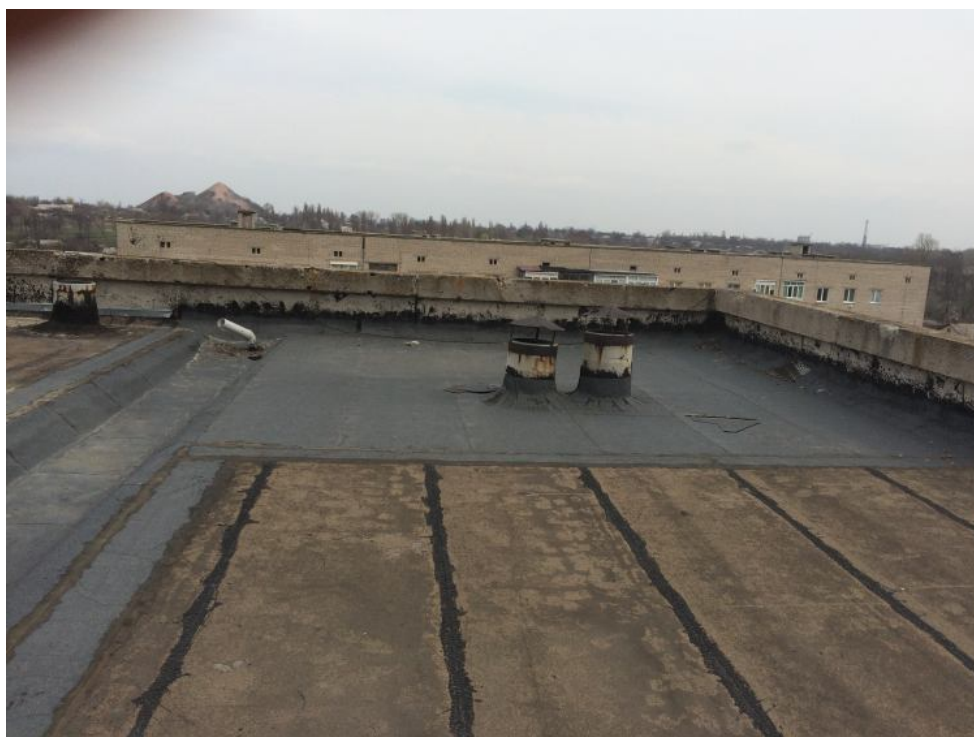
Рисунок 1 — Отсутствие защиты на парапетах
