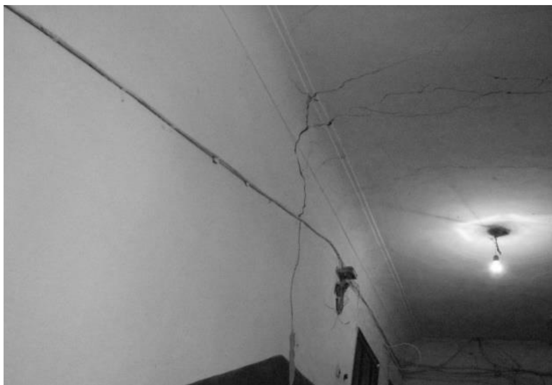
Рисунок 2 — Повреждения жилых домов в г. Горловке на горном отводе шахты «Кочегарка», в зоне влияния горных выработок глубиной более 500 метров
