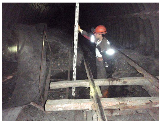
Рисунок 4 Ремонтные работы и подрывка почвы в грузовом уклоне гор. 956 м
