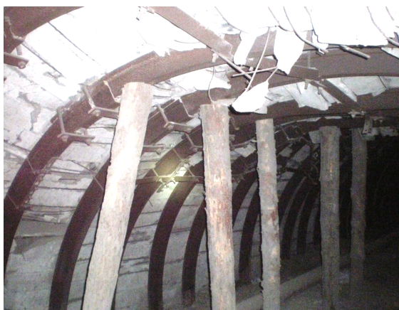
Рисунок 5 Повышение устойчивости арочной крепи установкой стоек в восточном полевом вентиляционном штреке гор. 714 м
