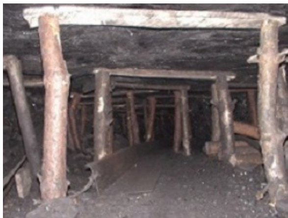
Рисунок 2 Простейшая деревянная крепь «две стойки под распил» при потере устойчивости стоек
