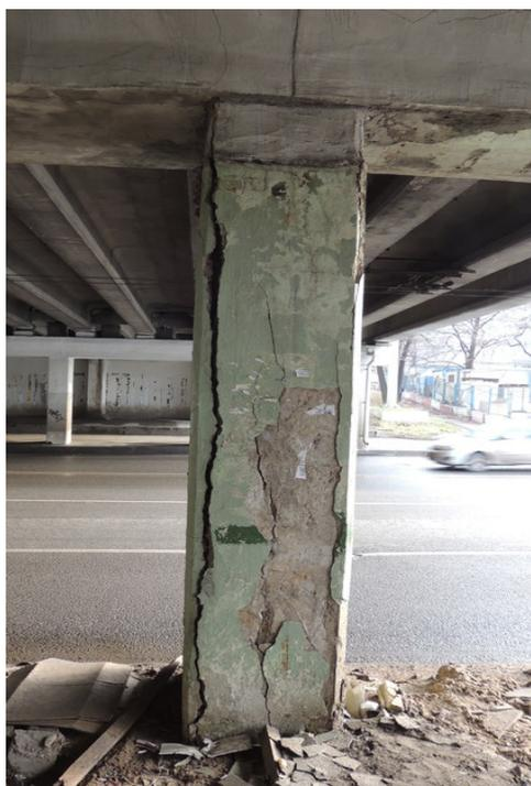
Рисунок 2 Разрушение сжатой бетонной колонны продольными трещинами раскола
